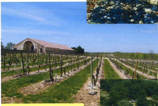
Château Haute Serre Cellar
